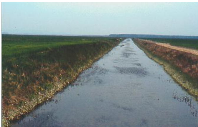
Slika 8: Otvoreni kanal I. reda
