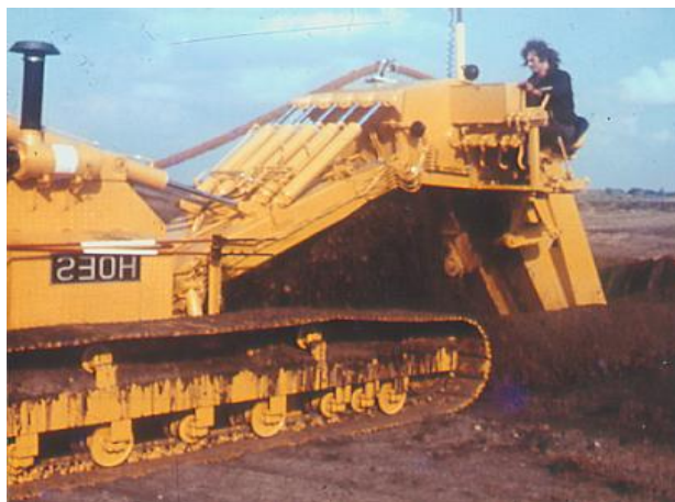
Slika 14: Polagač drenova u obliku freze
